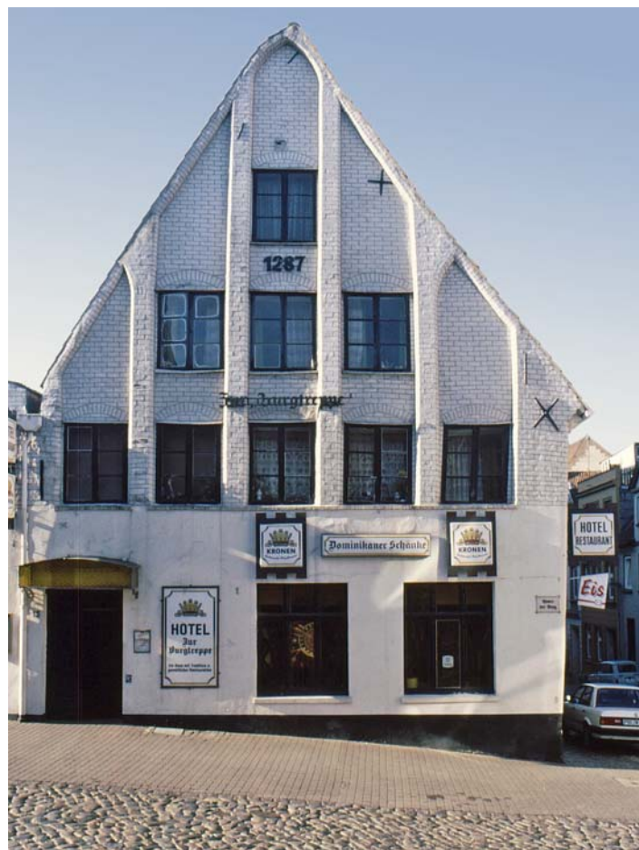
Oben: Fassade vor Beginn der äußeren Freilegung und Mauerwerkssanierung im Jahr 1990. Ein aufgemaltes Fugennetz suggeriert ein solides Mauerwerk. Tatsächlich waren aber alle jüngeren Fenster ohne Stürze eingebrochen und sogar Deckenbalken wie Unterzüge dafür zurückgeschnitten worden. Unten: Brandnacht an Pfingsten, Blick in die Kleine Burgstraße. Foto: Holger Krüger.
