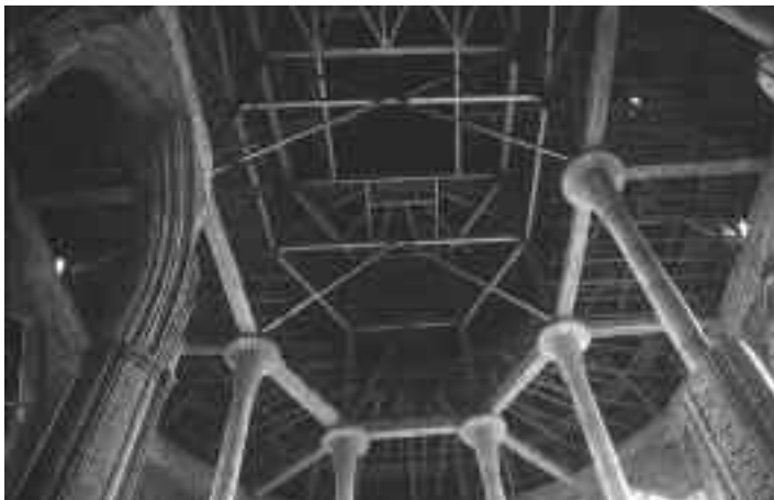
Chojna, Marienkirche. Der offene Dachstuhl über dem Mittelschiffs-Betonskelett
