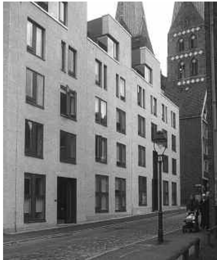
Preisgekröntes Internationales Studentenwohnheim Fischstraße / Alfstraße, hier die Fassade zur Fischstraße. Der Verzicht auf Backsteinsichtigkeit ist ein Fortschritt. Aber vielleicht darf's etwas mehr Farbe sein?
