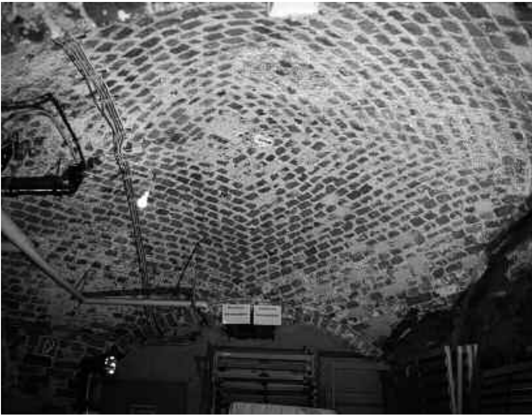
Oben: Die Gewölbe im Cranekonvent-Keller ähneln byzantinischen „Hängekuppeln“ – absolut ungewöhnlich in unseren Breiten
