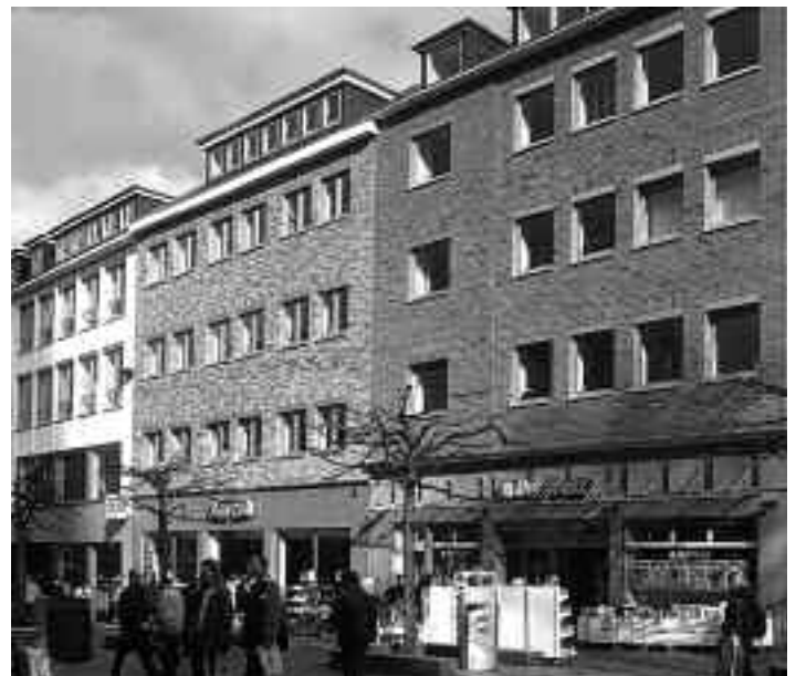
Gegen schlechte Investoren-Architektur kann der Gestaltungsbeirat offenbar auch nichts machen (Ostseite Breite Straße)
