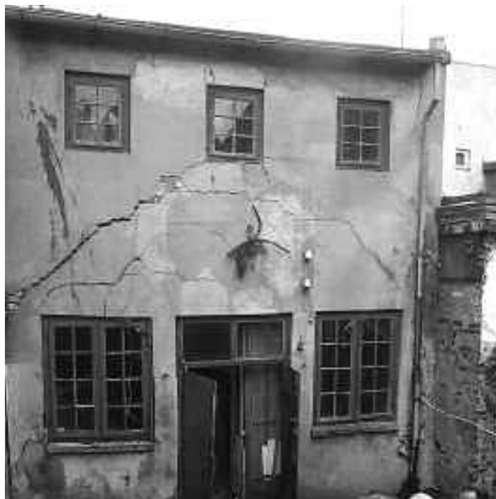
Hinteres Quergebäude: ehemals Werkstatt und Lager, später oben auch Wohnung. Könnte nach Sanierung wieder so ähnlich funktionieren.
