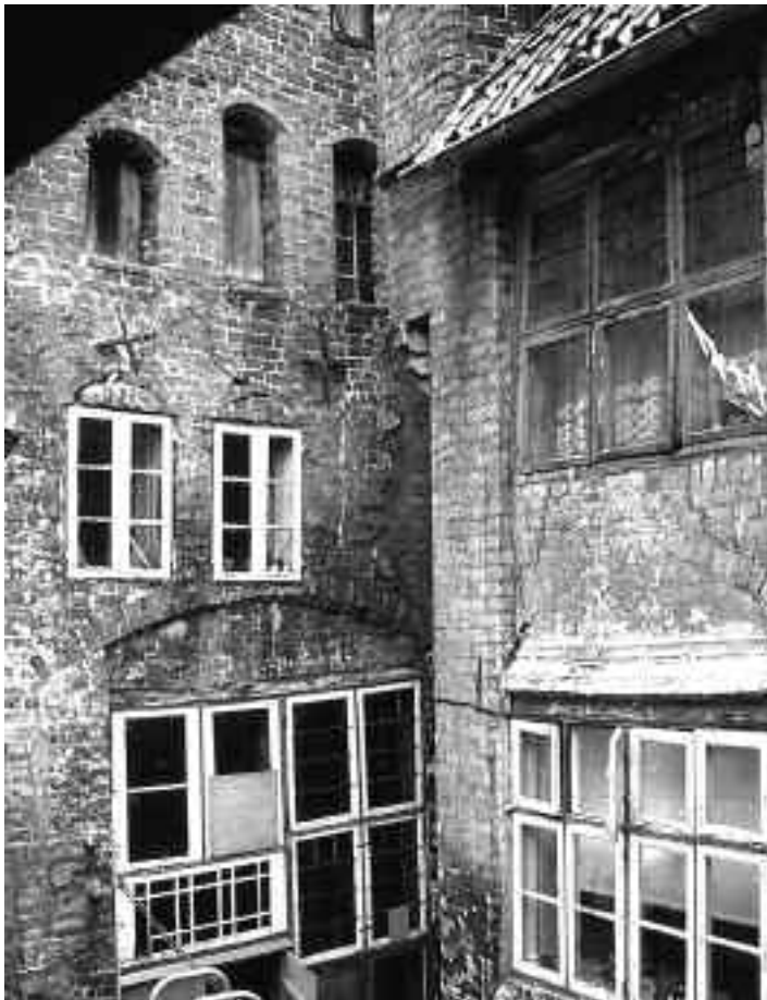
Fleischhauerstraße 79, Blick auf die Rückfassade mit dem großen Dielenfenster unten und auf den Flügelanbau rechts. Foto vor der Total-Eingrünung durch Efeu.
