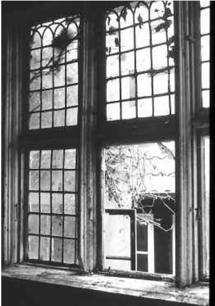
Fleischhauerstraße 79. Eines der kostbaren bleiverglaste Fenster im Flügel-Oberzimmer. Einmaliger Kulturschatz: Die ältesten erhaltenen Fenster in einem Lübecker Bürgerhaus mit der für die Spät-Renaissance typischen Zeichnung der Bleiruten. Hier noch unter der „Vereinbarung“ durch jahrzehntelang unbehindertes Efeu-Wachstum.
