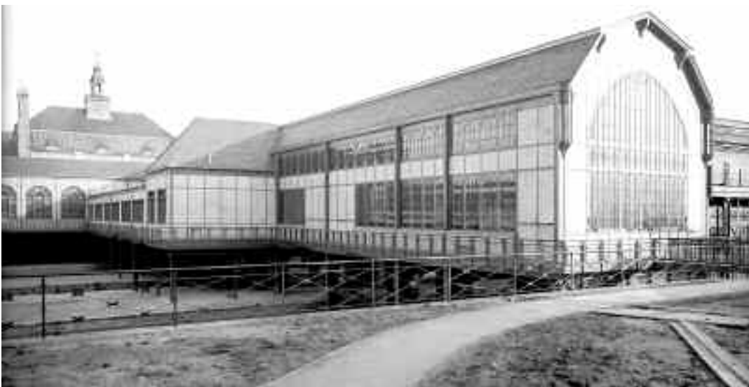
Die „obere Wandelhalle“, ein bis heute weitgehend erhaltener Eisenskelettbau, harrt nun seiner „Anhebung“
