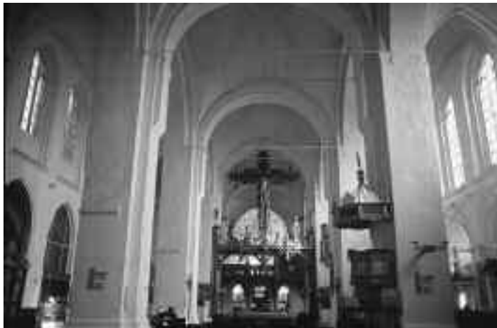
Das romanische Mittelschiff, begleitet von gleichhohen Seitenschiffen: aus der Basilika wurde eine Hallenkirche
