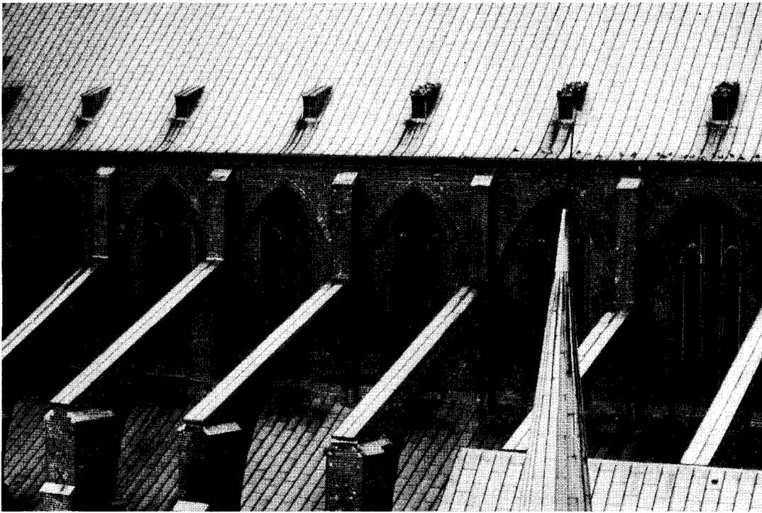
Langhaus von Süden. Die rechte Fensterlicht gehört noch zum Chor. Die ausgefeilte Statik läßt sich schön ablesen: tragendes Gerüst sind die vortretenden massiven Wandpfeiler. Zwischen ihnen spannt sich eine spitzbogige „Brücken“-Konstruktion, ein massiver „Aquädukt“ als Auflast. Die dazwischengesetzte Wand mit dem schmalen Fenster ist vergleichsweise dünn. Die Strebebögen wurden gemeinsam mit der Wölbung aufgesetzt.
