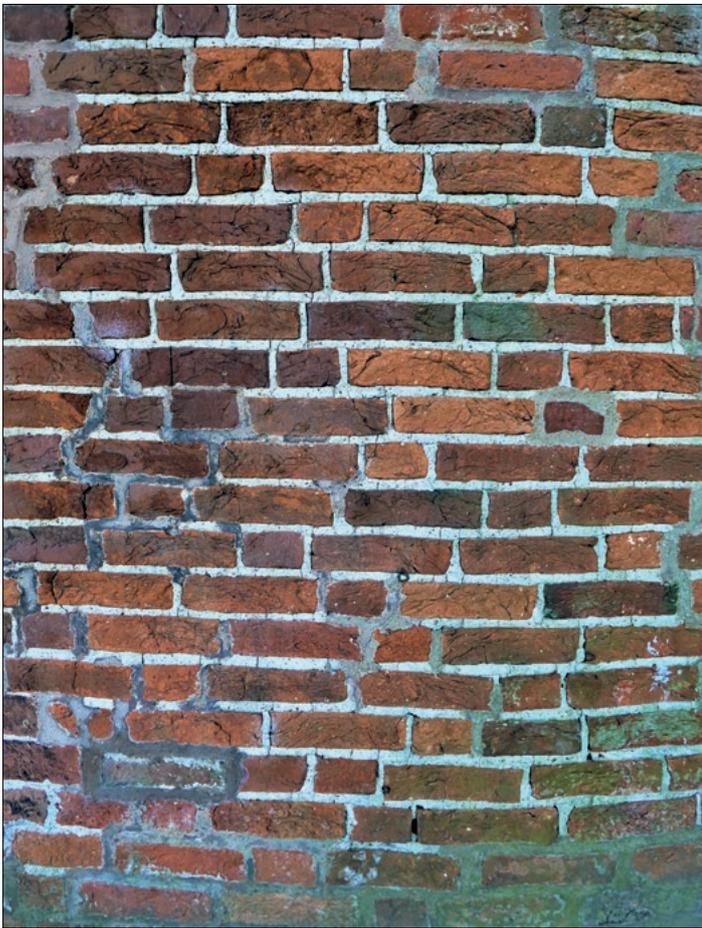
Am Kaiserturm unten: Mauerwerk von 1181. Die Steine sind 7,5 cm hoch („dick“), 27 cm lang und 12,5 cm breit und sind 1:2-Verband vermauert (2 Läufer, 1 Binder). Diese vorzüglich mit originalem Mörtel erhaltenen Partien gehören zu den frühesten Ziegelbauwerken in Nordeuropa. Erstaunlich auch die Material-Qualität der Ziegel, die es nachfolgend in solcher Perfektion selten gegeben hat.
