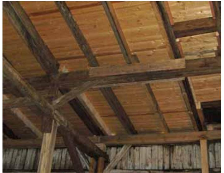
Oben: Schuppen B, nördliche Halle: Für kleines Geld hätte hier und dort ein Bitumenflicken genügt, um die Holzunterkonstruktion zu schützen. Nun wurde die geschädigte Holzschalung teils großflächig erneuert und mit neuen Bitumenschweißbahnen gedeckt.
