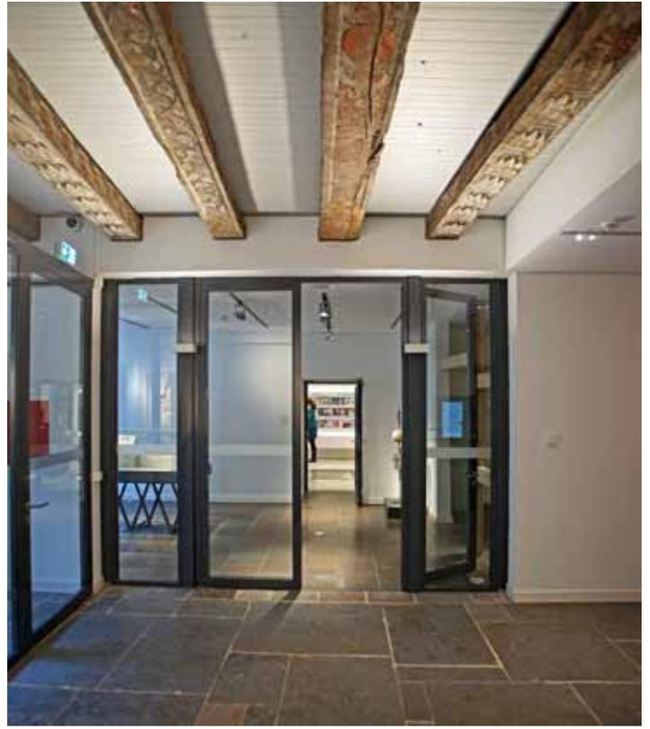
Oben: Deckenbalken mit ihren Bemalungen aus der Zeit der Renaissance sind innerhalb des spätklassizistisch umgestalteten Haupthauses stellenweise sichtbar gemacht und geben wie weitere Sichtfenster in den Brandwänden auf ältere Befunde Einblicke in die Baugeschichte des Hauses zurück bis in das Mittelalter.
