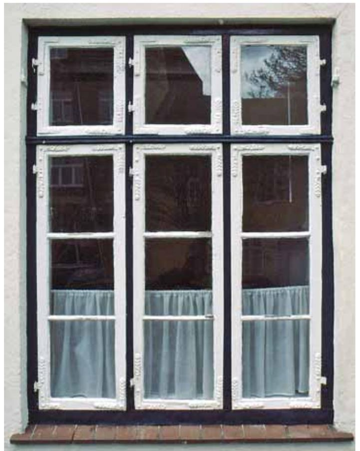
Unten: Kreuzstock des 16. Jhs., Fensterflügel neu aus dem frühen 19., die Beschläge (hier die Eckwinkel) sind wiederverwendete Stücke aus dem Barock mit dem typischen Ähren-Dekor. Eine originale und daher authentische Lübecker Befundlage. Nur: wie lange noch?
