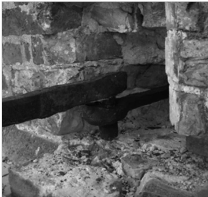
Bild linke Seite. Eine vom Hochschiff zum Strebepfeiler (rechts) geführte Zugstange. Die Zugkräfte haben Öse und Kloben verformt.
