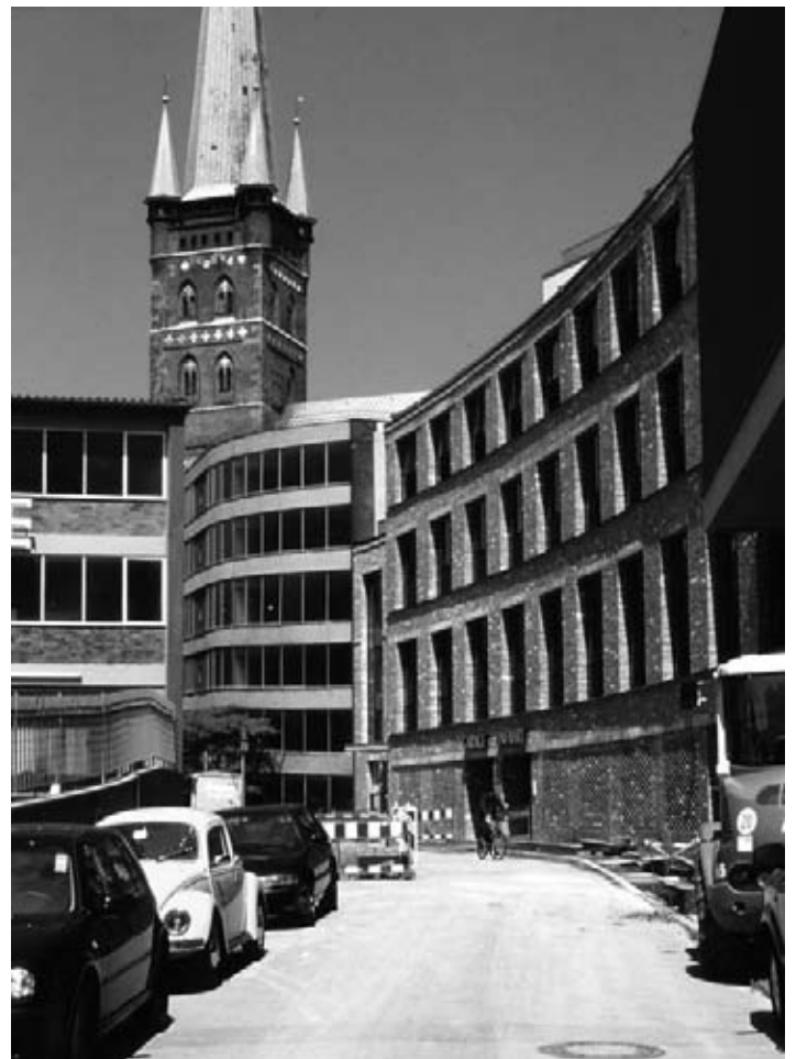
Kleine Kiesau mit dreigeschossigem Teil des Atlantik-Hotels. Angenehmere Raumbildung durch die gekurvte Führung der Front.
