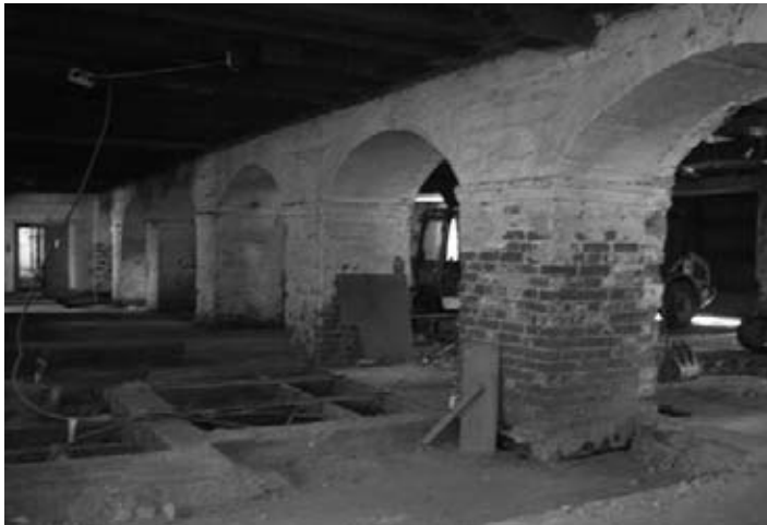
Schwedenspeicher Stralsund, Erdgeschosshalle. In den Obergeschossen hölzernes Ständerwerk. Eine der ertümlichsten Speicher-Landschaften wird unterteilt und durchbaut. Damit ist die Aussage als Bauwerk entwertet.
