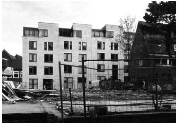
Gähn. Durch die weite Abbruchlücke zwischen Braun- und Fischstraße wird das langweilige Mittelmaß des Studentenwohnheims jetzt überraschend deutlich.
