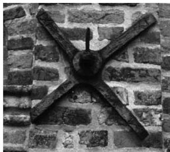
Barocker Kreuzanker an der Ägidienkirche aus korrosionsbeständigem Schweißseisen - ohne Zink und Farbe
