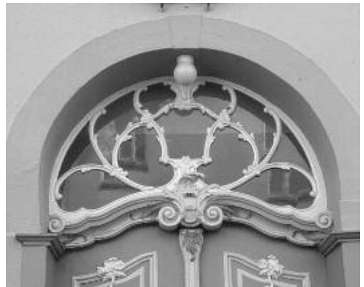
4 Glockengießerstraße 42. Rokoko um 1750/60. Im korbbogig umgeformten Bogenfeld bilden die wie natürliche Ranken sprießenden Sprossen ein großes „O“, dem ein kleineres Oval einbeschrieben ist. Ganz ähnlich Große Gröpelgrube 36 oder Kupferschmiedestraße 10 (die zugehörige Haustür wurde vor einigen Jahren „entsorgt“).
