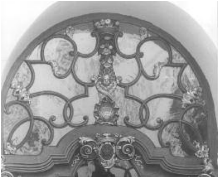
1 Engelsgrube 55. Lübecks ältestes und prächtigstes Oberlicht, um 1730 im spätbarockem „Bandelwerk“-Stil entstanden. Typisch die scherenartig sich kreuzenden Bänder auf dem Kämpfer. Muschel und Krone sind Dekor-Motive des Barock. 1982 Fassung in blaugrün mit Blattgold-Höhlung freigelegt bzw. nach Befund wiederhergestellt. Zugehörige Tür nicht erhalten, die zugehörige Barockfassade im 19. Jahrhundert biedermeierlich vereinfacht. Damals wurde auch das unpassende Oberlicht hinter einer Platte verbaut.
