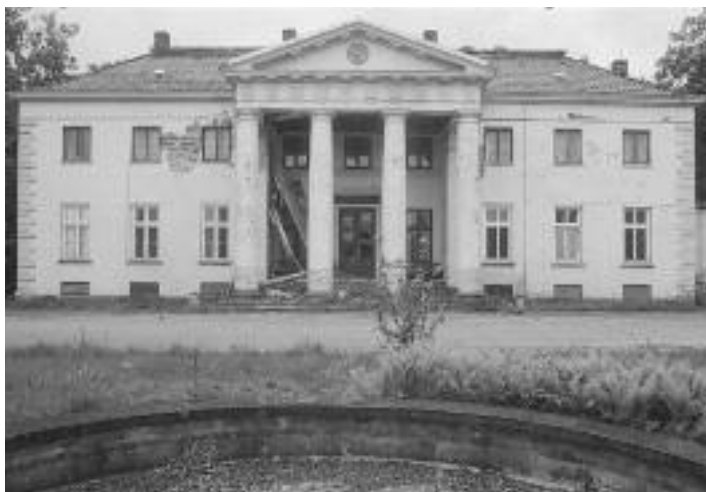
Gut Lehsen (bei Wittenburg), Herrenhaus. Eines der Hauptwerke von J. Chr. Lillie. Foto 1999. Nachfolgend entstellende „Rekonstruktion“. Wegen katastrophalen Schwammbefalls nur Außenmauern erhalten
