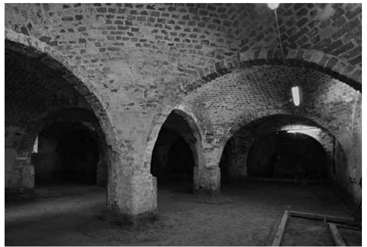
Der Gewölbekeller des Kranenkonvents. Die Umnutzung zur Mensa für die „Kleinen“ der Ernestinenschule nebenan ist im Gange (Foto: J. Sellerbeck).
