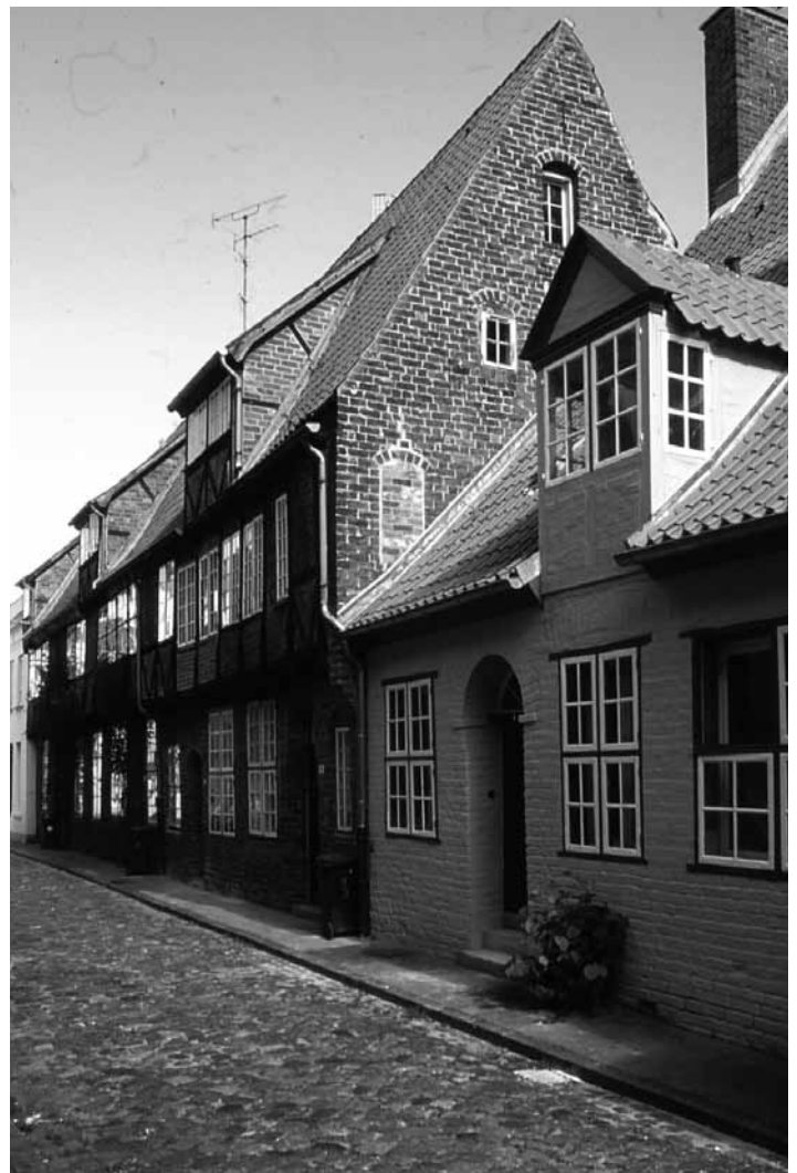
Düvekenstraße, Nordost-Seite. Vorn die eingeschossigen Häuser 13 und 11. Nr. 7 ist die vierte Einheit der zweigeschossigen Reihenhauseinheit links. Foto: M. Finke
