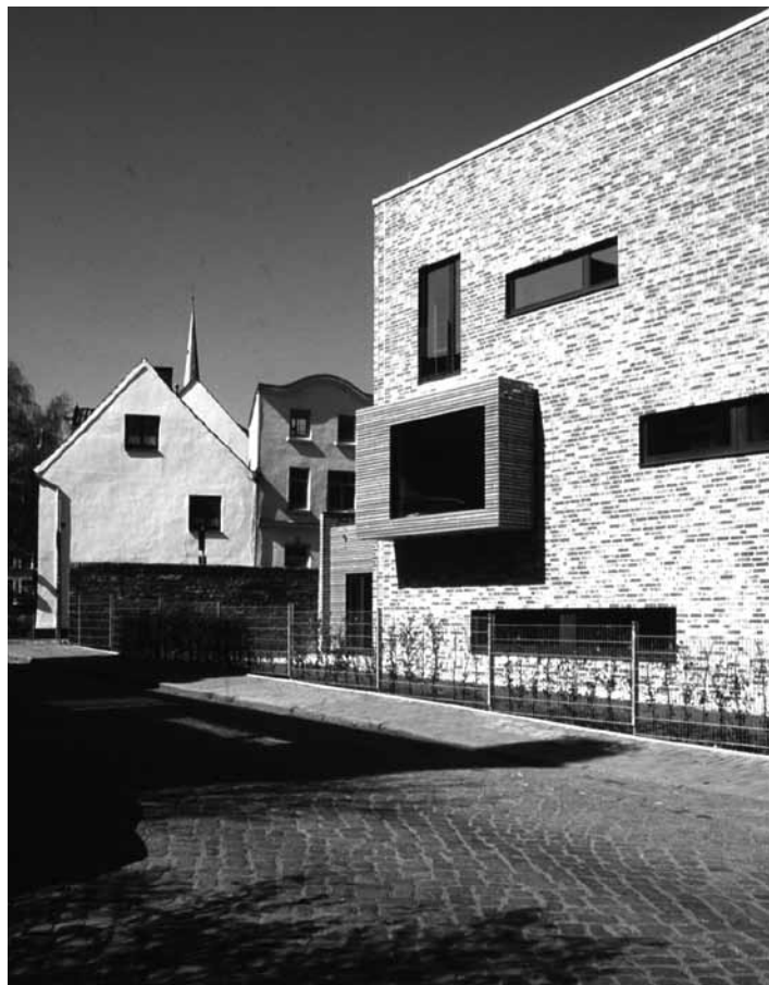
Der Kinderturm von Südosten. Lage und Größe der Fenster in der Mauerfläche sind von der Funktion bestimmt (KiTa, Saal). Das ist genau so beim neuen Bürohaus am Kölner Rheinhafen (kleines Bild unten), nur spielen da keine Kinder, sondern Computer. Bild oben: M. F.
