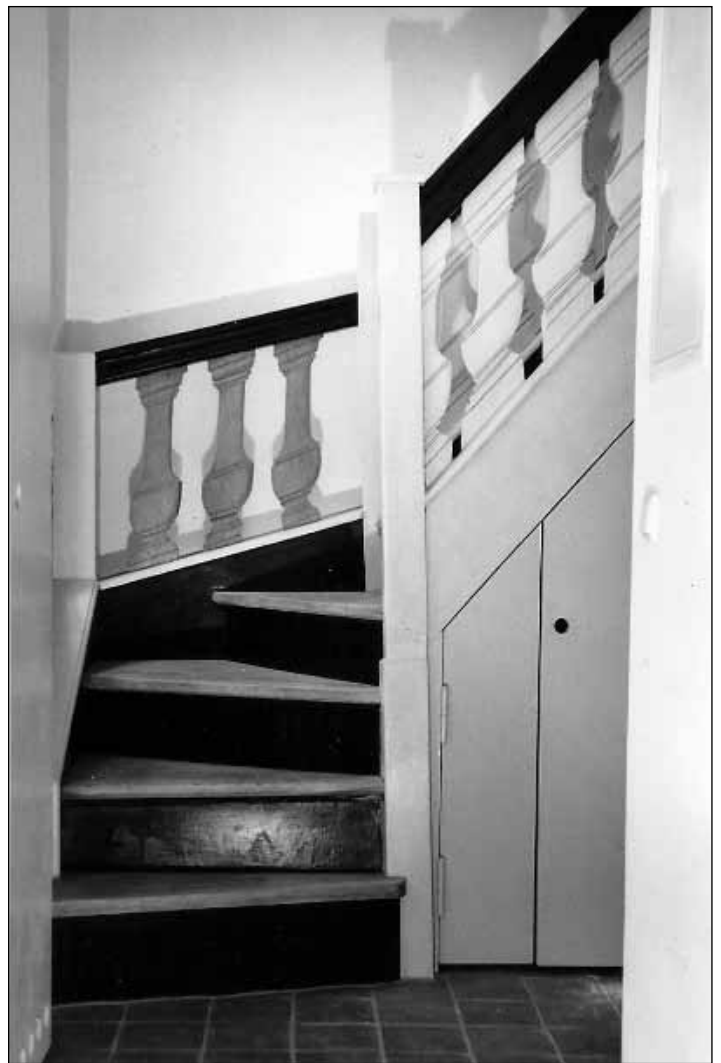
Düvekenstraße 1. Treppe des Barock mit besägten Brettern, deren Bemalung massive Baluster vortäuscht. Fotos: Eileen Wulff
